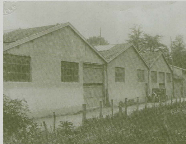
Arrière des bâtiments
