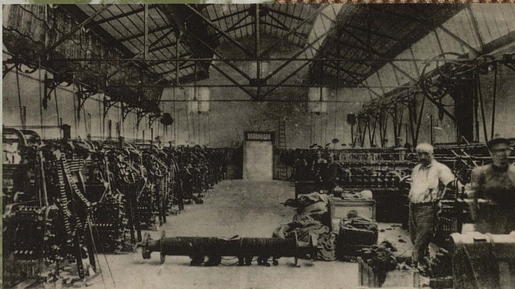
Verrières sur châssis métallique à l'usine Houard et Lalazée
